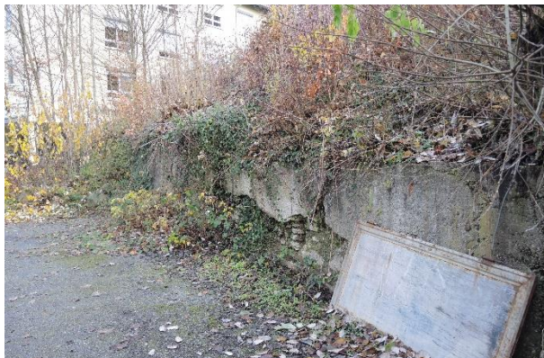
Stützmauer im Norden
