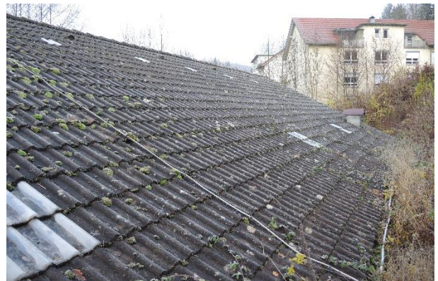
Dachzugänglichkeit vom im Osten gelegenen Hang
