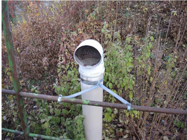
Entlüftungsrrohr der Garage „Betriebsgebäude“
